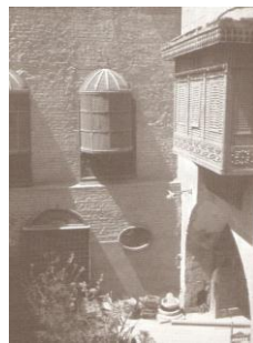
Mashrabiya di kawasan Arab Timur Tengah, memberikan ventilasi, keteduhan dan juga pendinginan dengan penguapan.
